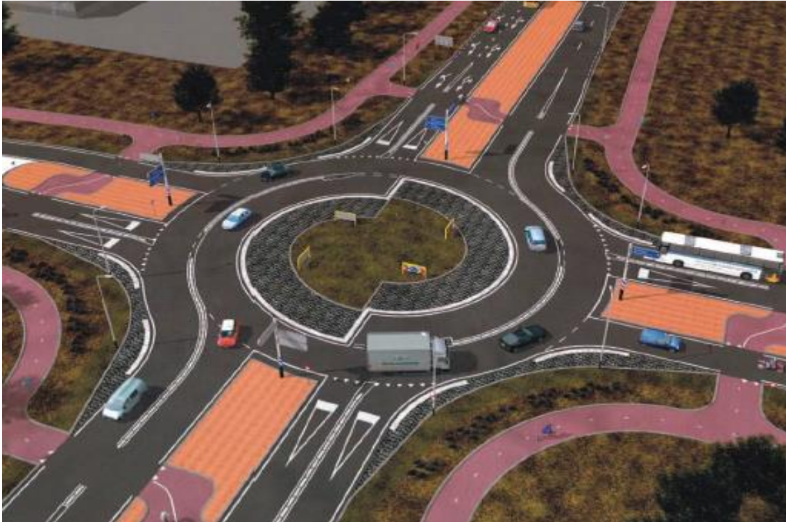
Figur A.1 Skråfoto af hollandsk turbo modelrundkørsel. Bemærk brugen af "fiskekrogs-pile" i den øverste tilfart, som ikke er tilladt i Danmark i forbindelse med rundkørsler.
